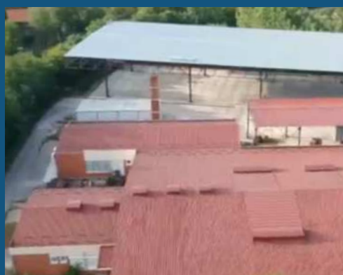
LAK PRILAZ ZA KAMIONE I SLEPERE
